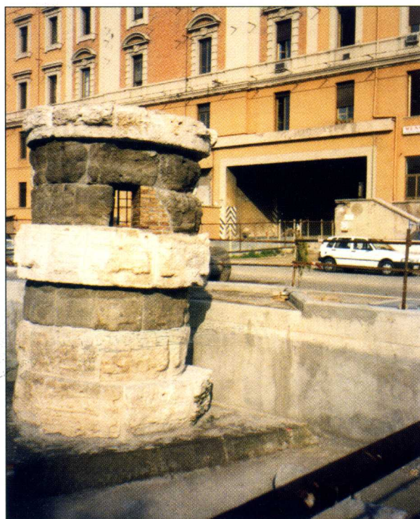
Ryc. LXXVIII. Dzielnicowy zbiornik rozdzielczy Aqua Marcia przed dworcem kolejowym Roma Termini. Fot. M. Biernacka-Lubańska.
